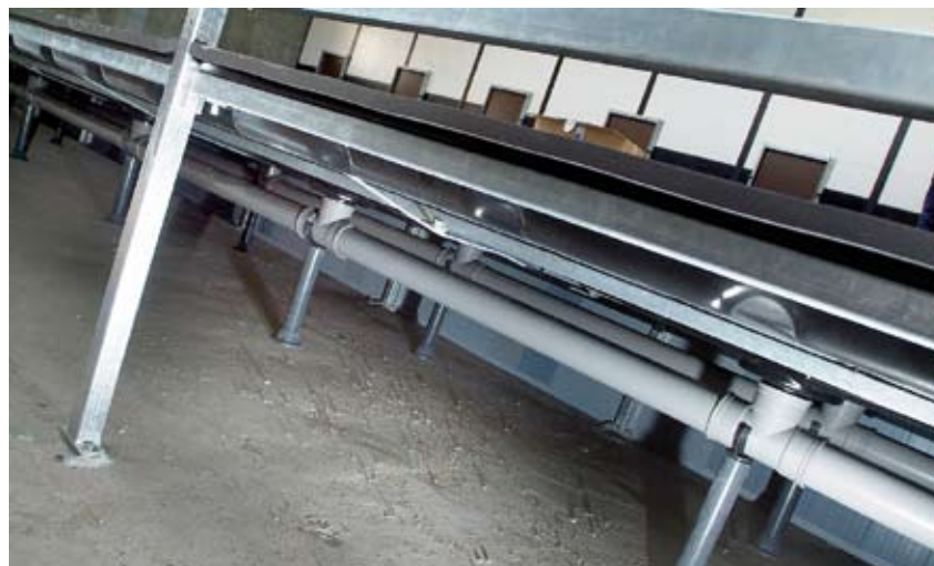
De dragers van het frame worden met bouten in de betonvloer verankerd
